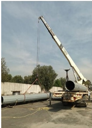
Obra civil poste tronco cónico conformada por una pila de 12 m de profundidad y dado de cimentación Trabajo realizado en diciembre de 2024
