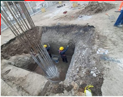
Obra civil poste tronco cónico conformada por una pila de 12 m de profundidad y dado de cimentación Trabajo realizado en diciembre de 2024
