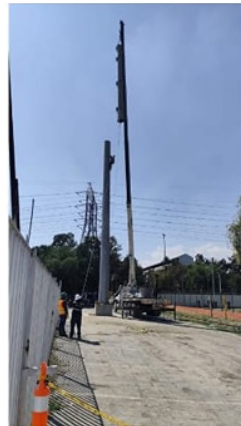
Montaje de poste tronco cónico
