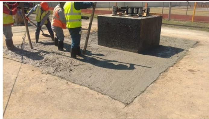
Obra civil poste tronco cónico conformada por una pila de 12 m de profundidad y dado de cimentación Trabajo realizado en diciembre de 2024
